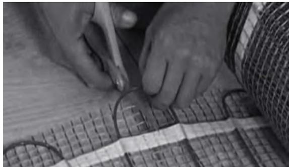
Upewnij się, że BVF H-MAT jest bezpośrednio przymocowana do podłogi na całej powierzchni. Unikaj wchodzenia na umieszczoną matę grzewczą. Jeśli jest to nieuniknione, użyj gładkiego obuwia. W przypadku unoszenia się kabla grzejnego nałóż gruby klej lub taśmę klejącą bezpośrednio na punkty.
