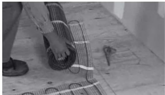
Po dotarciu do różnych przeszkód (prysznic, toaleta itp.) Ostrożnie wyjmij kabel grzejny z siatki i poprowadź go wokół przeszkody. W niektórych przypadkach konieczne może być częściowe lub całkowite usunięcie sieci. Pamiętaj, że cięcie kabla jest zabronione! Użyj kleju lub taśmy klejącej do zamocowania usuniętego kabla na podłodze.
